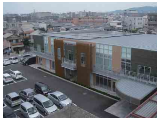
恋の産未来発電所@ならコープ (年間発電量46,142 kWh(平成26年度))
